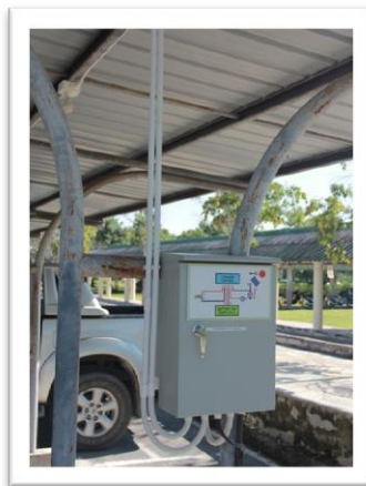
ภาพที่ 4 และภาพที่ 5 การติดตั้งตู้ควบคุมและแผงวงจรโซลาร์เซลล์บริเวณโรงจอดรถ
