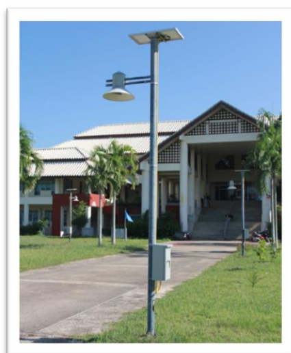
ภาพที่ 2 การติดตั้งแผงวงจรโซลาร์เซลล์บริเวณด้านหน้าอาคารศูนย์บรรณสารและสื่อการศึกษา
